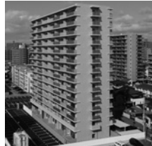
ジェイグラン大元 ●所在 / 岡山市北区 ●主な構造・規模 / RC造14F ●戸数 / 82戸 ●引渡時期 / 2023年3月
